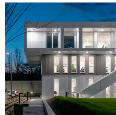
Siège social de Nordnet, Villeneuve d'Ascq, France, 2019 Client : Thema Propoerties. Surface : 4.300m 2 . Programme : siège social. auditorium 200 pl., cafétéria, salles de commission, espace fitness, espace détente, bar, espaces rencontres extérieurs et intérieur.
