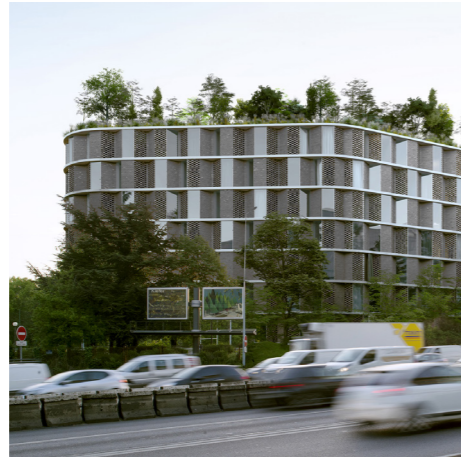
Fondation de Chine, Paris, France, 2022 Client : Beijing Capital Land . Surface : 8 840 m 2 . Programme : CINASPIC 300 ch. étudiants. 1 logement directeur et 1 studio, 1 salle polyvalente ERP 400 pl., 3 salles de musique, 2 salles d'études, 1 foyer étudiant, toitures végétalisées accessibles. En collaboration avec l'Atelier FCJZ.
