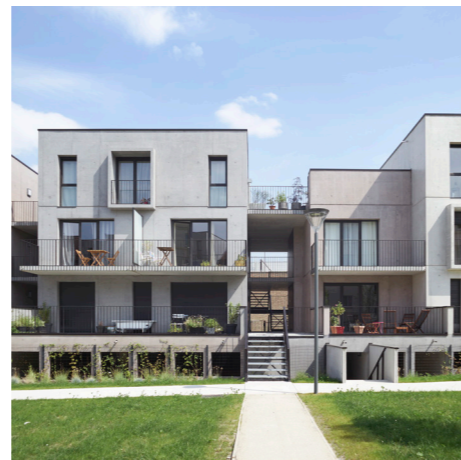
Land'Art, Lille, France, 2016 Client : Pierre & Territoires de France Nord. Surface : 5400 m 2 . Programme : 29 logements sociaux, 8 maisons individuelles, 20 logements collectifs, 22 logements intermédiaires, une crèche.
