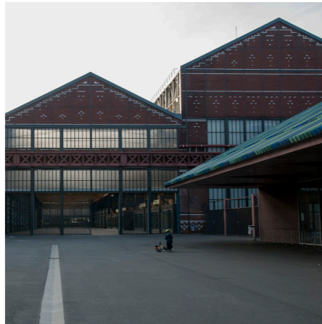
Lycée Hôtelier International de Lille (LHIL), France, 2016 Client : Ville de Lille - Conseil Régional Nord Pas-de-Calais. Surface : 21.450m 2 . Programme : Lycée international des métiers de l'hôtellerie, de la restauration et de l'alimentation. Salle de sports polyvalente, internat et logements de fonction.
