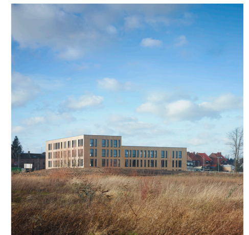
Quartier des Docks, Cambrai, France, 2015 Client : Groupe Financière Duval. Surface : 15 500m 2 . Programme : ensemble de bureaux, parc tertiaire.
