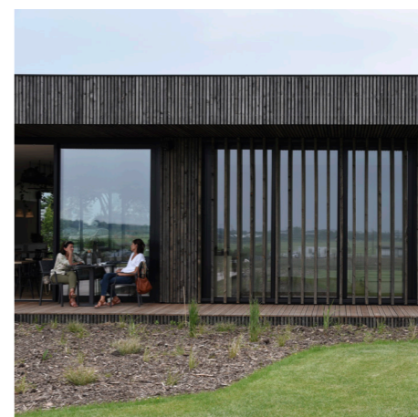
Villa Yoga, Bondues, France, 2018 Client : SCI Arpatoli. Surface : 865m 2 . Programme : Centre de bien-être, salles de yoga, cafétéria - structure bois.
