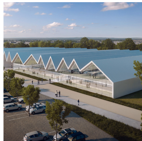
Campus OVH, Roubaix, 2016 (phase 1) Client : Groupe OVH. Surface : 12.000m 2 - phase 1: 2.700m 2 . Programme : Siège social comprenant 200 bureaux, 1 auditorium 350 pl., 1 salle de sports, des espaces de détente
