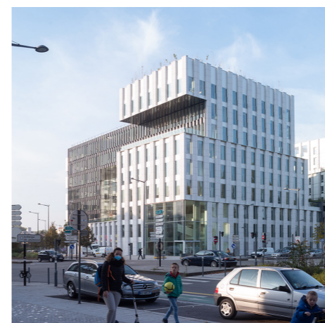
Ensemble mixte Partenord, Lille, France, 2020 Client : Partenord Habitat. Surface : 14 733 m 2 . Programme : Siège social Partenord Habitat, bureaux locatifs, 50 logements. Avec TAG Architectes, Paindavoine Parmentier Architectes.
