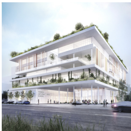
Lycée Français International de Hong Kong, Chine, 2015 Client : Lycée Français International. Surface : 20.000m 2 . Programme : école (du primaire au lycée), installations sportives dont piscine intérieure, gymnase, auditorium 300 pl., cantine 1000 pers.
